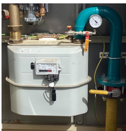
Figure 6 : Exemple de compteurs d'électricité, de gaz et d'énergie thermique.
